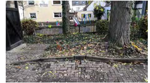
An dieser Stelle sind durch Baumwurzeln Stolperfallen im Pflaster entstanden. Damit sich hier niemand verletzt, haben wir die Stadt gebeten, die Fläche zu erneuern. Provisorisch wurde das unebene Pflaster bereits entfernt und eine Schotterschicht aufgetragen. Im Frühjahr erfolgt die komplette Erneuerung. Danke dafür an das Grünflächenamt!
